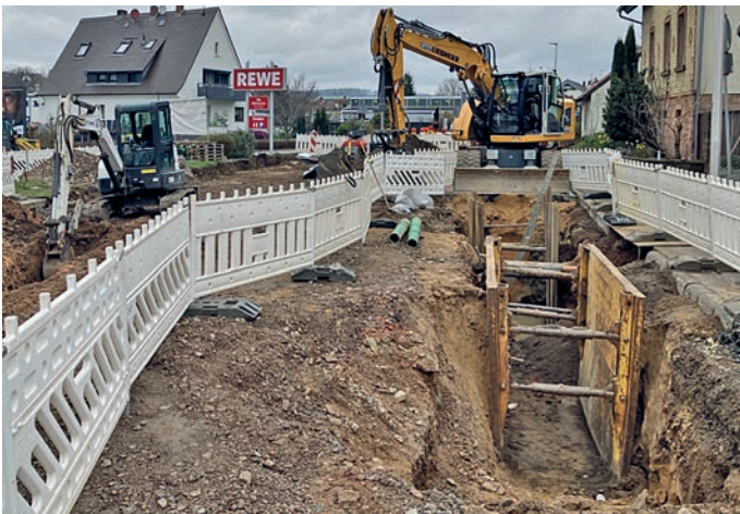
Abb.: Kanalbauarbeiten
