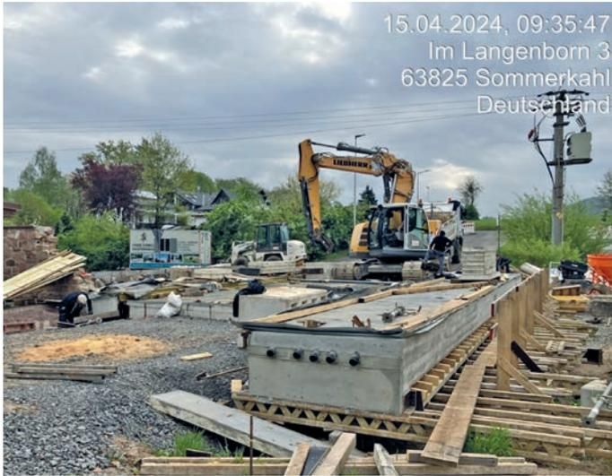
Abb.: Fertigstellung der Betonarbeiten an den Brückenkappen
