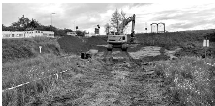
Abb.: Baggerarbeiten zur Herstellung der Behelfsbrücke
